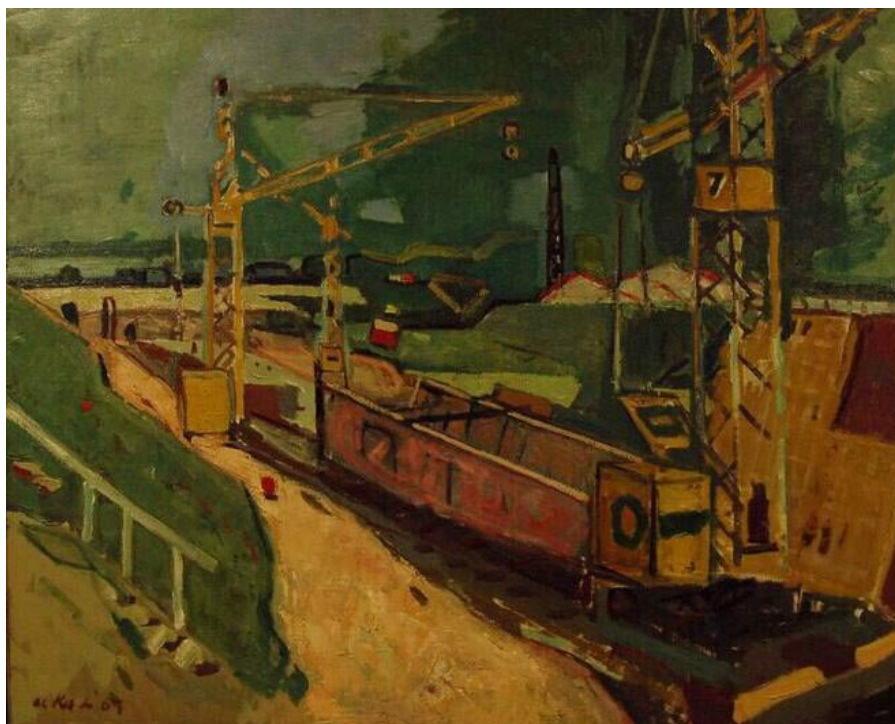
Bouw van de Coentunnel, Otto B. de Kat, 1967
